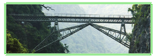
Viaduc du Faux-Namti, Chine, 1910 (voir page 16)
